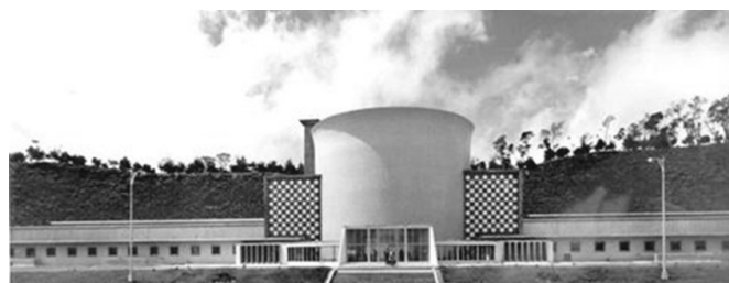
Fig. 5. Edificio del Reactor, IVIC, Altos de Pipe.
